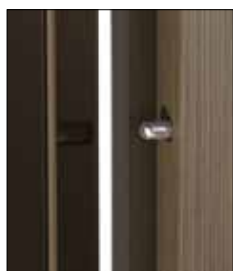
BEZPEČNOSTNÍ TRNY PROTI VYSAZENÍ V KOMPLETU SE ZÁRUBNÍ ZDARMA BEZPEČNOSTNÉ TRNE PROTI VYSADENIU
